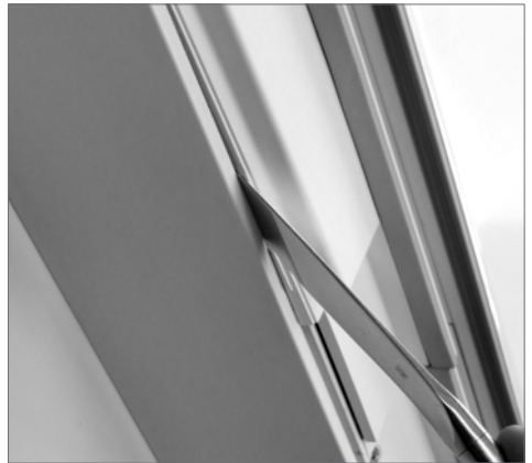
Öffnen des Revisionsdeckels
