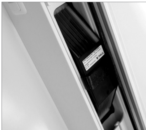
Ausrichten des Wärmetauschers
