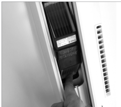
Herausziehen des Wärmetauschers
