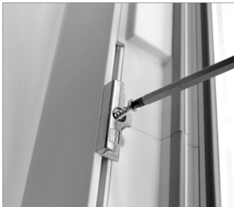
Verschrauben der Schließstücke
